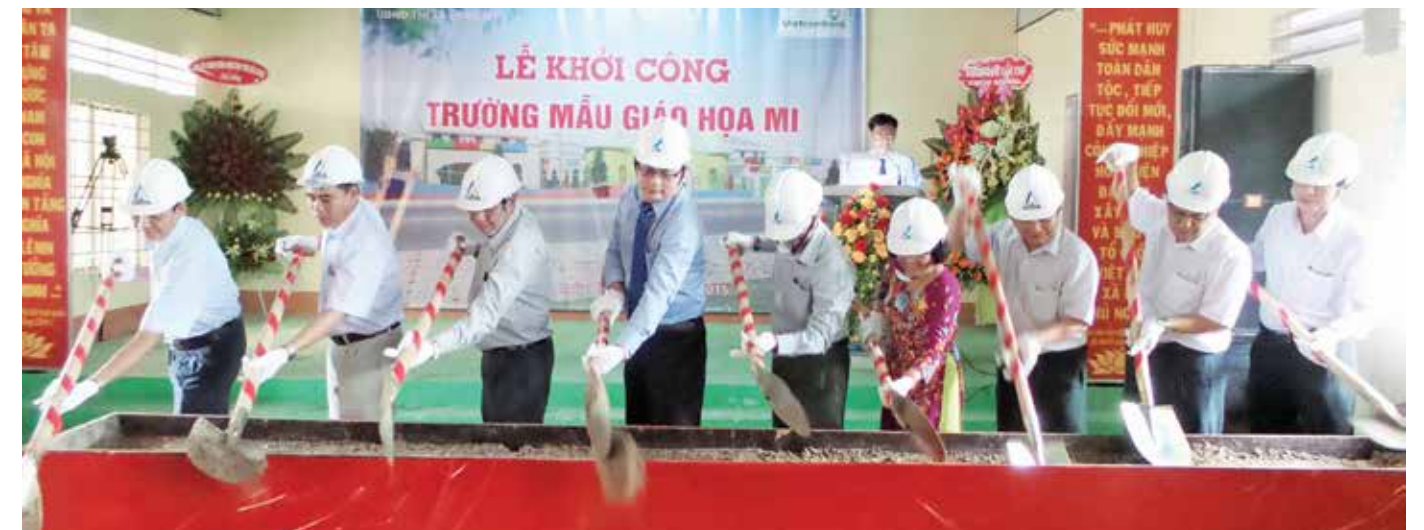
Đại diện Vietcombank cùng các ban ngành trên địa bàn huyện Long Mỹ thực hiện nghi thức khởi công xây dựng công trình Trường mẫu giáo Hòa Mi
